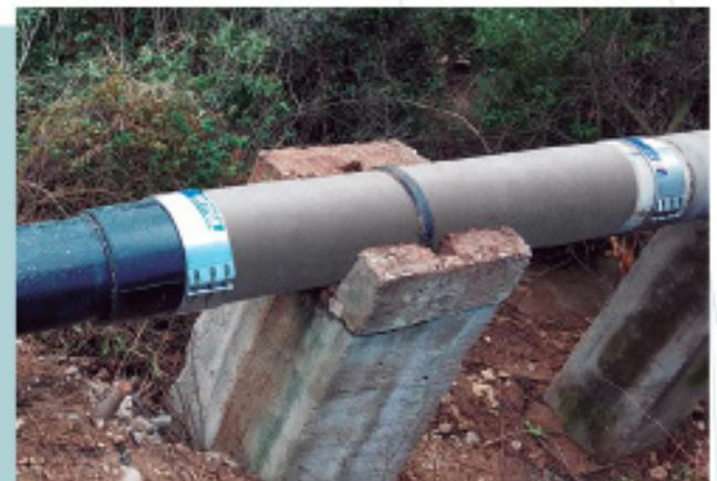
◆ Riparazione di tubazione aerea di differenti diametri e materiali
