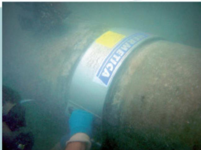
◆ Montaggio sottomarino. Giunto di tenuta fabbricato in acciaio inossidabile
