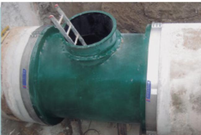
◆ Installazione del pozzetto di ispezione per tubazioni di grande diametro
