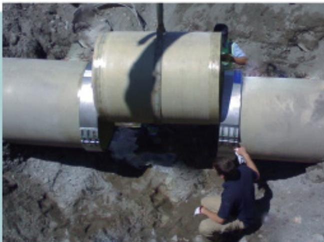
◆ Riparazione con tratto di tubo in tubazione di grande diametro in FRP
